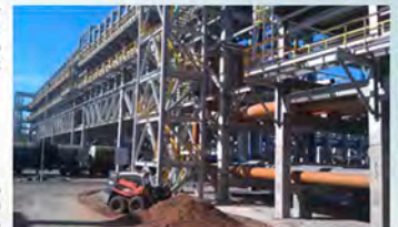
Строительство ангара в п. Безымянном.
